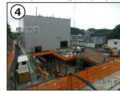
④-1 横浜坑口施工状況(R4.10時点)
