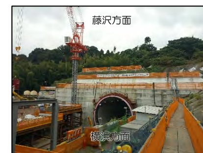
④-2 横浜坑口施工状況(R4.10時点)
