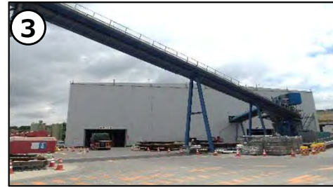
③-1 発進立坑地上設備(R4.7時点)
