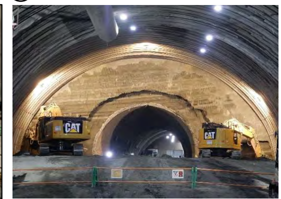
③ 庄戸トンネル大断面区間 施工状況(R4.7時点)
