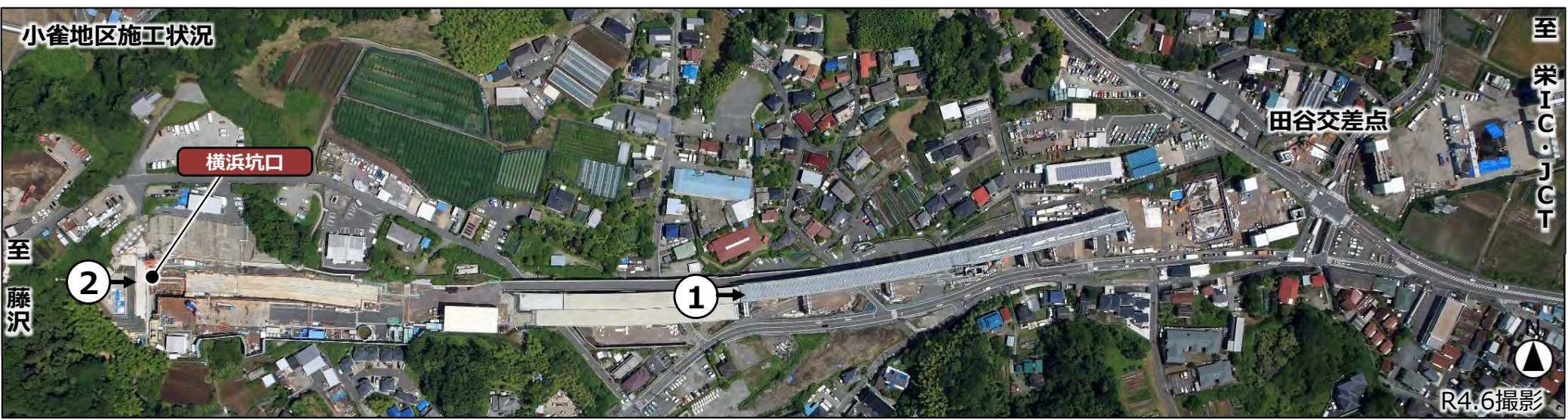
① 小雀高架橋上部工事 施工状況
