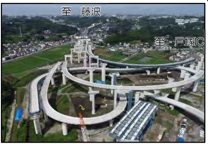
①-2 上部工施工状況(R4.7時点)
