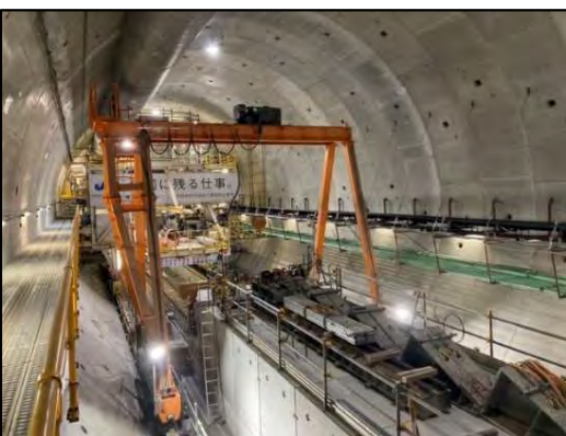
② 桂台トンネル坑内 施工状況(R4.7時点)
