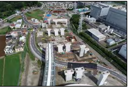
①-3 下部工施工状況(R4.7時点)
