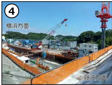
④-1 横浜坑口施工状況(R4.7時点)
