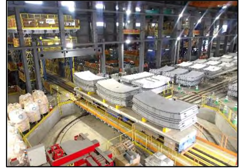
③-2 発進立坑地上設備内部(R4.7時点)
