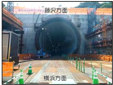
④-2 横浜坑口施工状況(R4.7時点)
