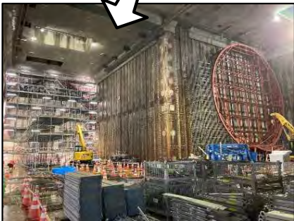
① 藤沢回転立坑施工状況(R4.7時点)
