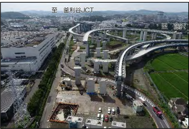
①-1 栄IC・JCT 施工状況(R4.7時点)
