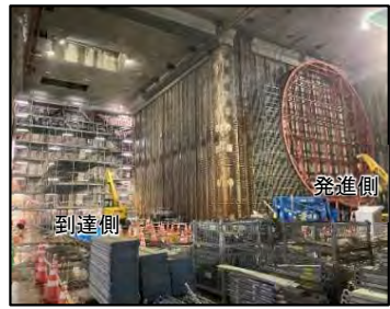
<回転立坑内の状況>
