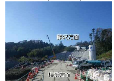
④-2 横浜坑口施工状況(R1.12時点)
