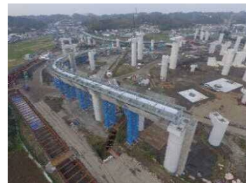
①-2 上部工施工状況(R1.10時点)
