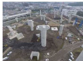
①-3 下部工施工状況(R1.10時点)
