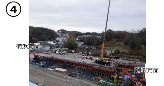
④-1 横浜坑口施工状況(R1.12時点)
