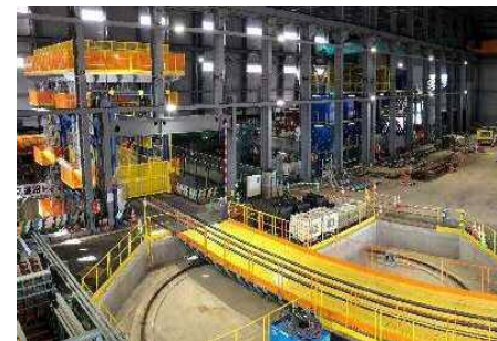
③-2 発進立坑地上設備内部(R1.12時点)
