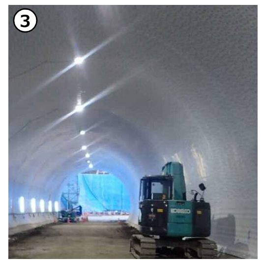
③釜利谷東トンネル 施工状況(R1.12時点)
