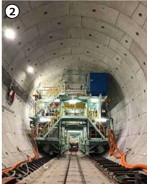
②シールド坑内施工状況(R1.12時点)
