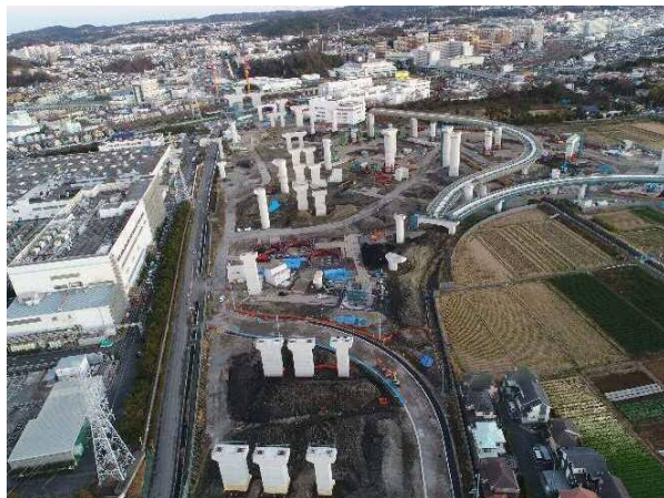
①-1 栄IC・JCT 施工状況(R1.10時点)
