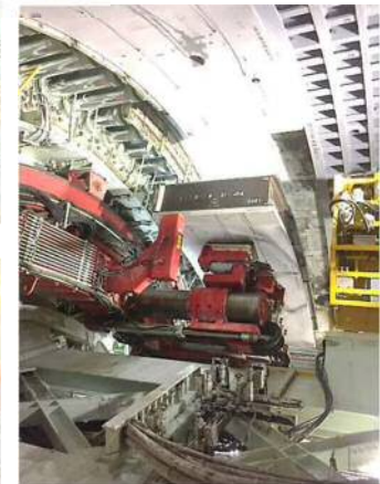
③エレクターの油圧駆動化
