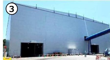
③-1 発進立坑地上設備(R1.12時点)
