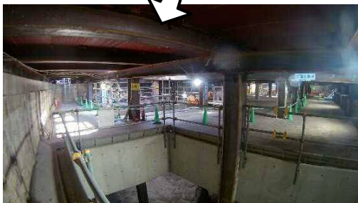
①藤沢回転立坑施工状況(R1.12時点)
