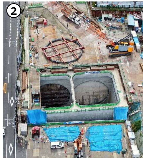
② 桂台トンネル発進立坑 施工状況(R1.6時点)
