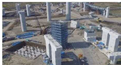
①-3 下部工施工状況(R1.6時点)
