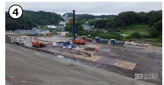
④-1 横浜坑口施工状況(R1.6時点)
