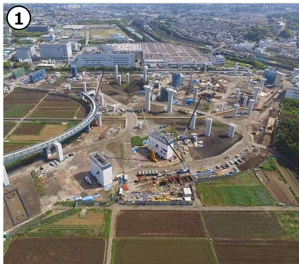
①-1 栄IC・JCT 施工状況(R1.6時点)
