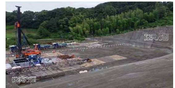
④-2 横浜坑口施工状況(R1.6時点)
