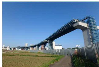
①-2 上部工施工状況(R1.6時点)
