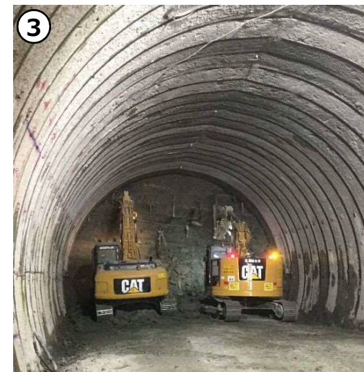
③ 釜利谷東トンネル 施工状況(R1.6時点)
