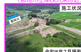
施工状況 令和8年7月撮影 j) 那須烏山市下境地区（那珂川左岸62.0k付近）
