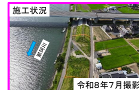
施工状況 令和8年7月撮影 b) ひたちなか市勝田地区（那珂川左岸4.0k付近）
