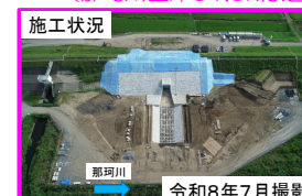
施工状況 令和8年7月撮影 g) 常陸大宮市大場地区（那珂川左岸33.5k付近）
