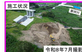
施工状況 令和8年7月撮影 f) 常陸大宮市大場地区（那珂川左岸31.5k付近）
