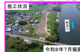
施工状況 令和8年7月撮影 c) 水戸市吉沼地区（那珂川右岸8.0k付近）
