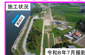
施工状況 令和8年7月撮影 d) 水戸市吉沼地区（那珂川右岸8.5k付近）
