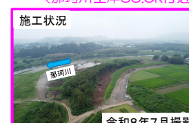
施工状況 令和8年7月撮影 i) 那須烏山市下境地区（那珂川左岸61.5k付近）
