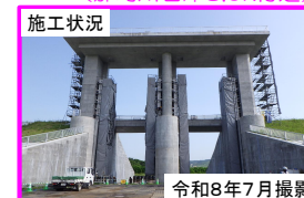
施工状況 令和8年7月撮影 e) 常陸大宮市大場地区（那珂川左岸31.5k付近）
