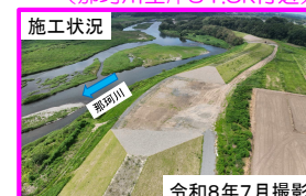
施工状況 令和8年7月撮影 h) 那須烏山市下境地区（那珂川左岸60.0k付近）
