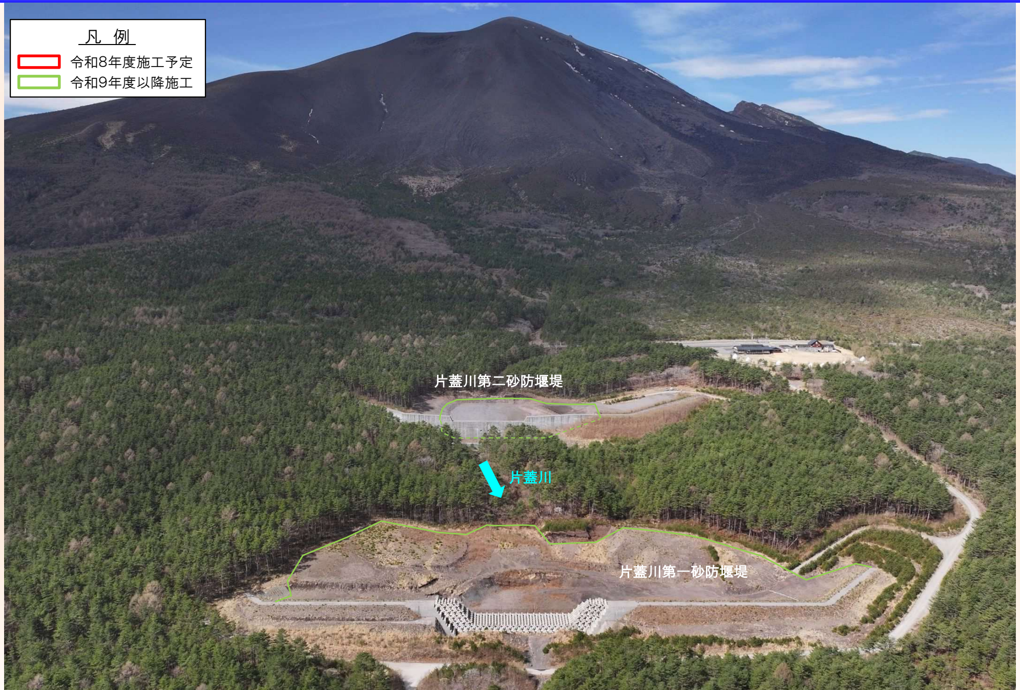
片蓋川第一・第二砂防堰堤（下流から望む） 2026. 4. 22 撮影
