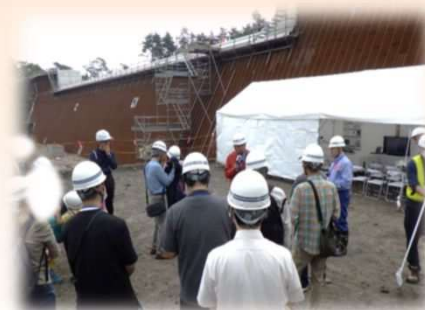
砂防施設と施工現場の見学
