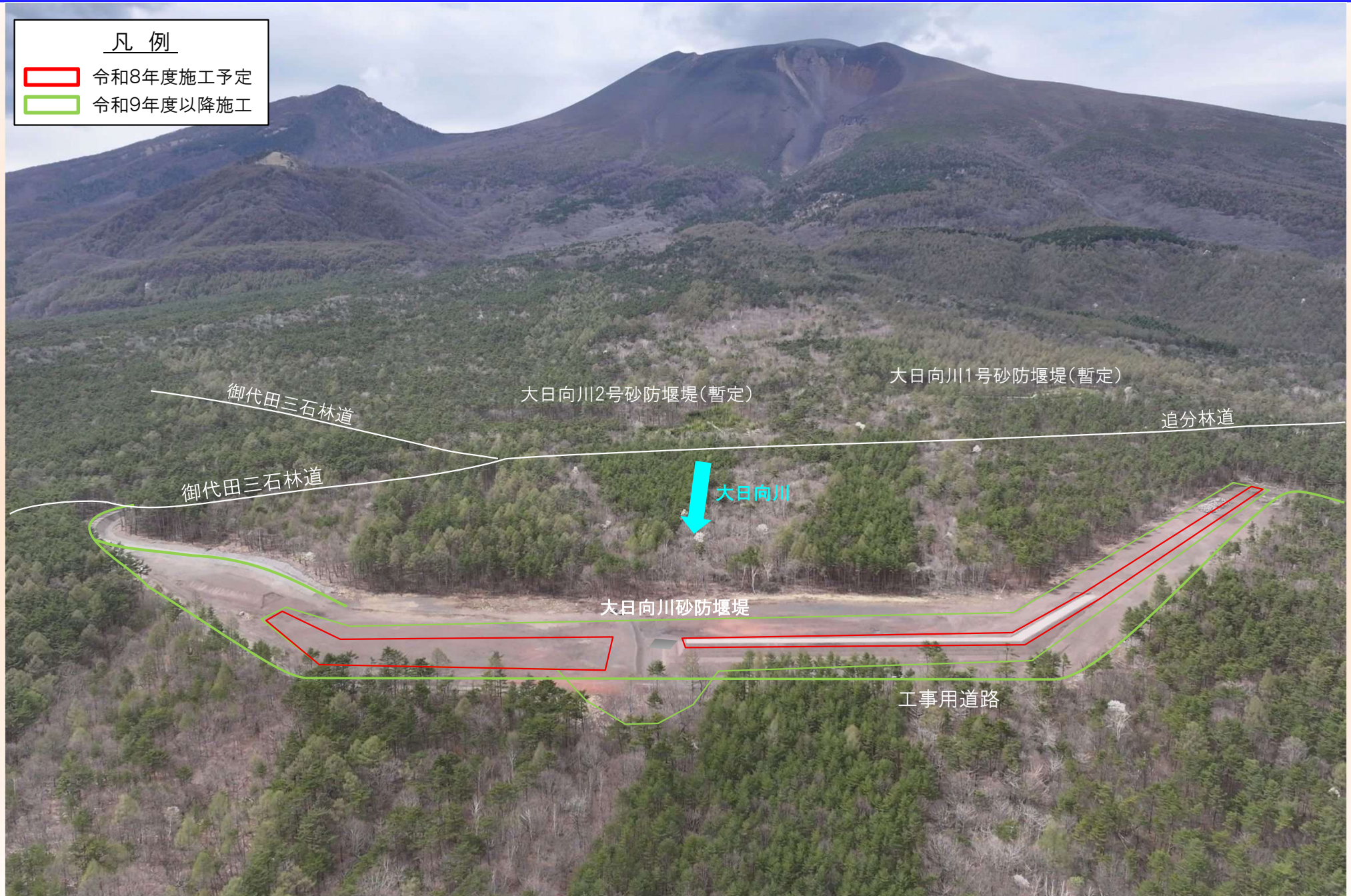
大日向川砂防堰堤（下流から望む）
