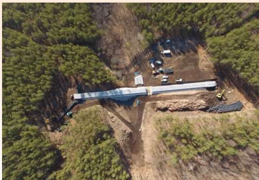
船ヶ沢川東(長野県) 堰堤工
