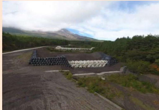
片蓋川(群馬県) 捕捉工
