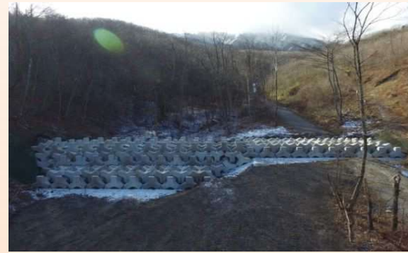
東泉沢(群馬県) 堰堤工
