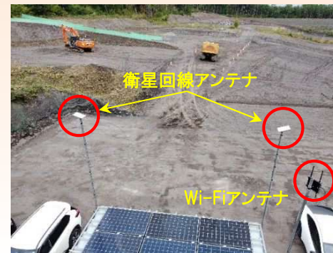
施工現場（基地局）の 衛星回線アンテナ設置状況
