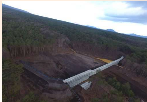
濁川(長野県) 堰堤工
