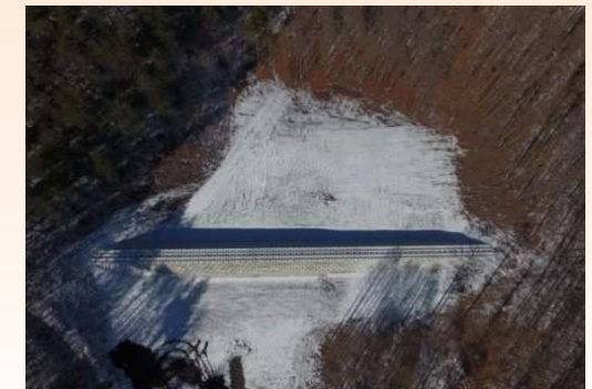
千ヶ滝西沢(長野県) 堰堤工
