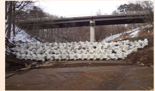
蛇堀川(長野県) 堰堤工
