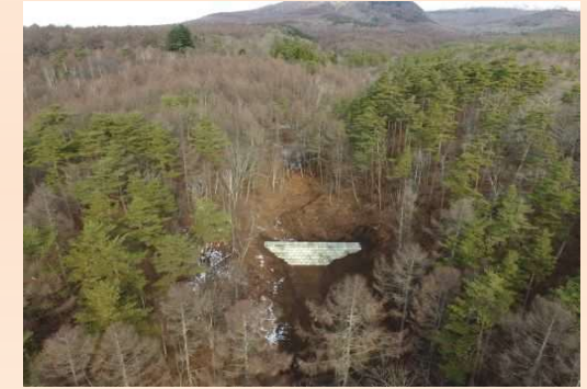
船ヶ沢川西(長野県) 堰堤工
