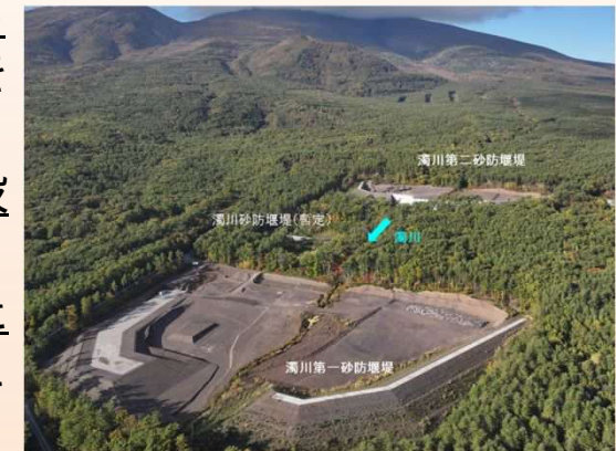
無人化施工現場 （濁川第一砂防堰堤）
