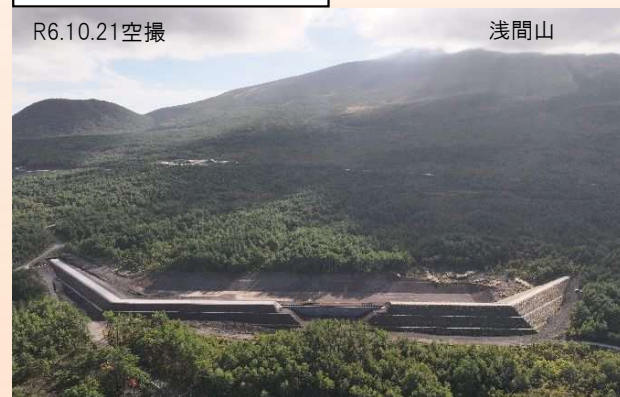
地蔵川第二砂防堰堤
