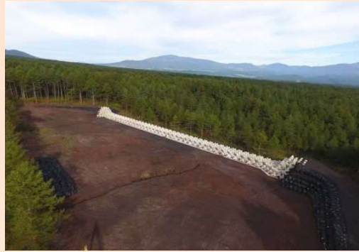
濁沢(群馬県) 堰堤工
