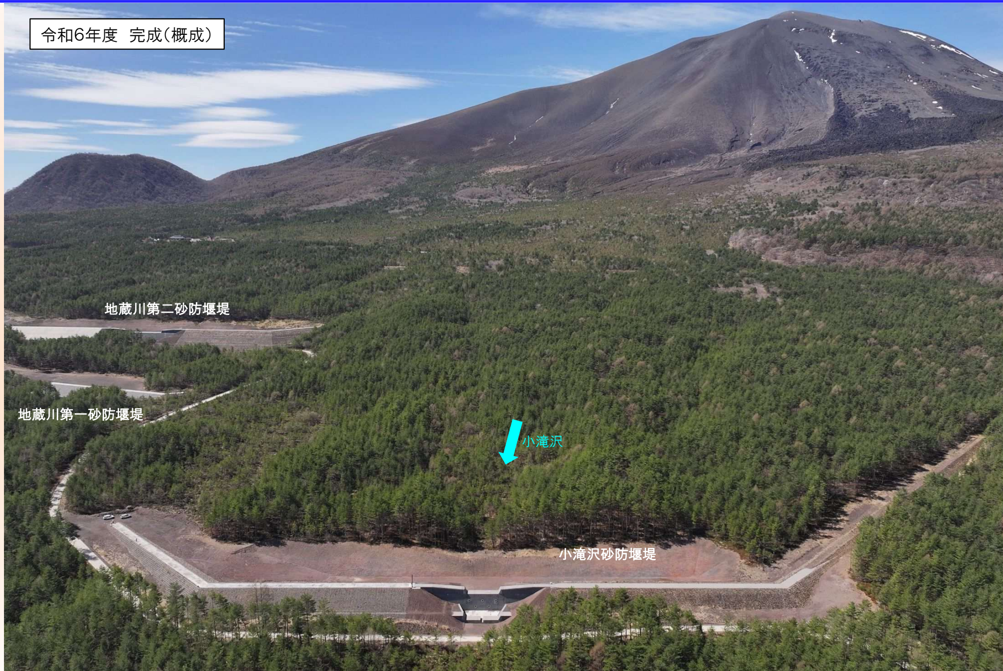
小滝沢砂防堰堤（下流から望む） 2026. 4. 22 撮影
