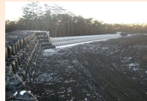
大日向川(長野県) 堰堤工
