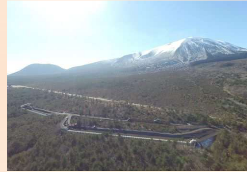
地藏川・小滝沢(群馬県) 堰堤工
