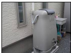
貯留槽の整備事例（富士市）
