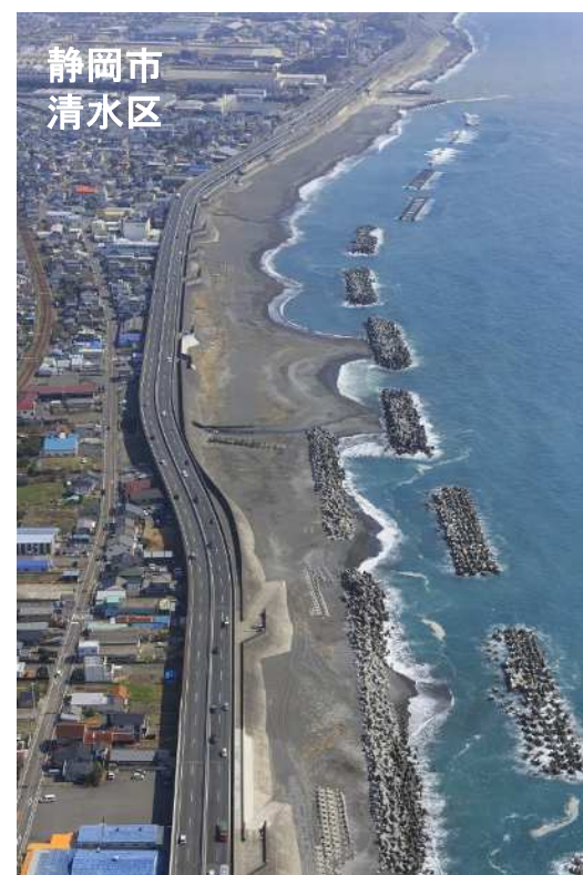
背後地を守る海岸保全施設
