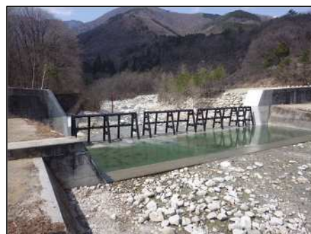
尾白川第三砂防堰堤
