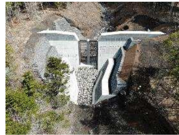
大久保第2砂防えん堤工 (R6年度完成)
