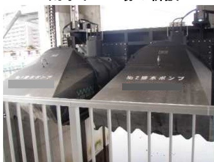
雨水ポンプ場の新設
