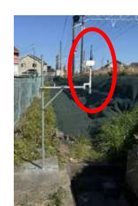
簡易水位計による水位情報の提供
