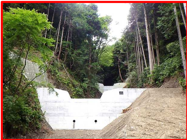
谷止工により山脚の固定及び土砂流出を防止
