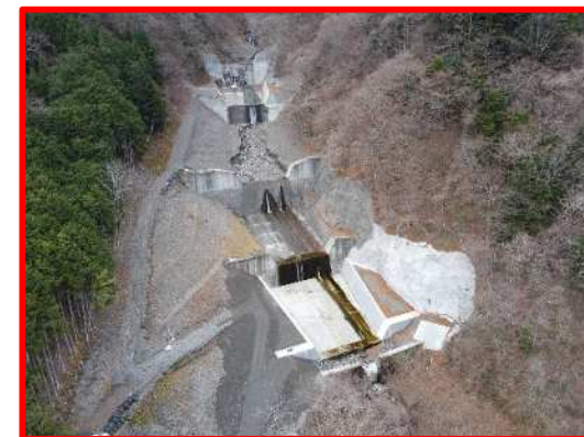
池の沢第二砂防堰堤工事(R7年度完成)
