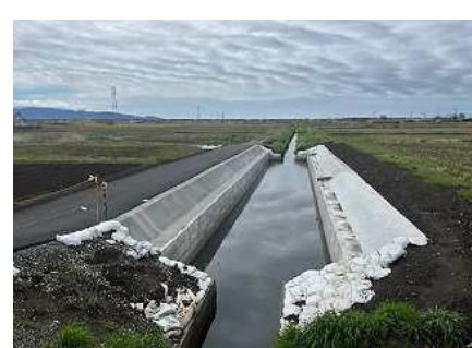
雨水排水路の改修
