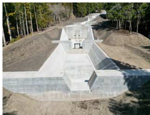
塩島沢第三砂防堰堤(R5年度完成)
