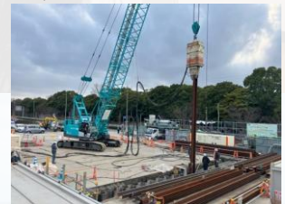
鋼矢板打込状況
