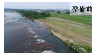
R1鬼怒川 右岸81k付近
