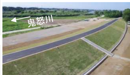
H27.9決壊箇所付近の築堤状況
