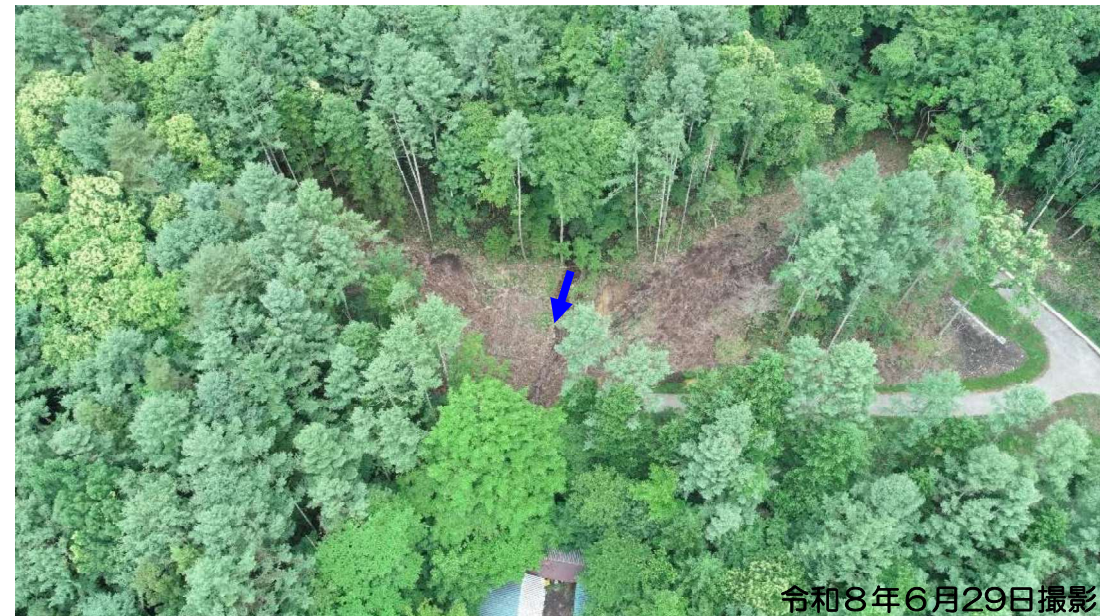
堂沢砂防堰堤の基礎部(地盤改良)工事着手前状況
