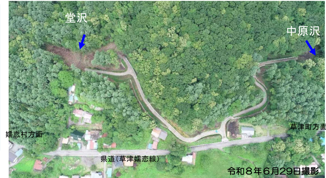
工事着手前状況(全景)
