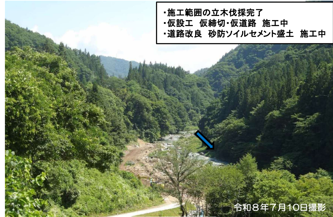
工事用道路(全景)
