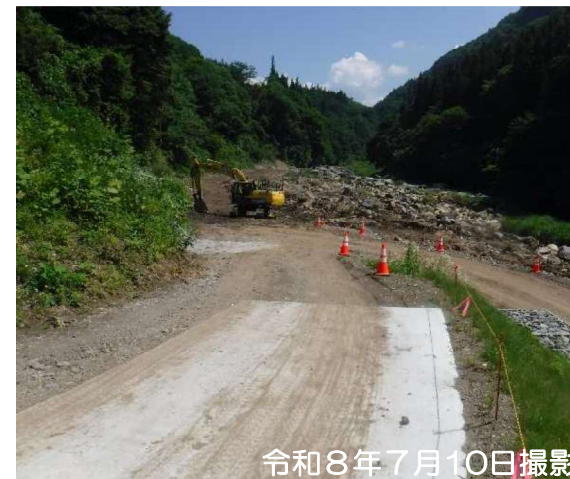
工事用道路(近景) 起点から終点方向を望む
