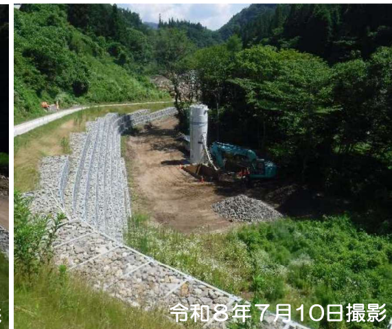
工事用道路(近景) 砂防ソイルセメント製作ヤード
