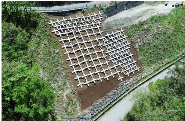
法面工事完成状況
