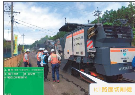
ICT舗装修繕工（路面切削工） 現場見学会
