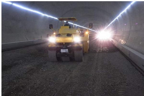
トンネル内路床工
