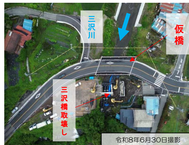
三沢橋取壊工 施工状況
