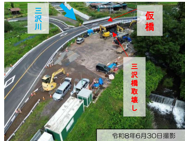
三沢橋を上空から
