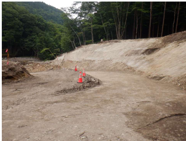
③ 撮影日：R8. 7. 9 ◆ No.50付近 道路土工 路床完了
