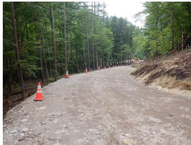
④ 撮影日：R8. 7. 9 ◆ No.43付近 道路土工 路床盛土完了
