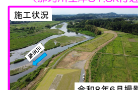
令和8年6月撮影 i) 那須烏山市下境地区（那珂川左岸60.0k付近）
