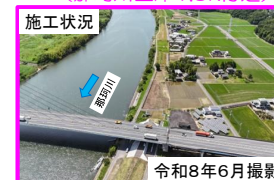
令和8年6月撮影 c) ひたちなか市勝田地区（那珂川左岸4.0k付近）
