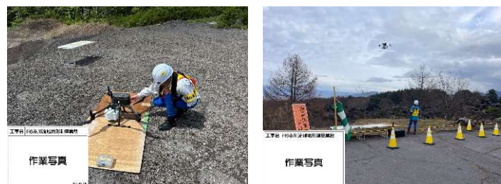
測量作業 (UAV準備)
