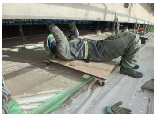
桁下断面修復の状況
