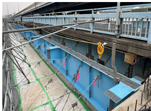
桁架設完了
