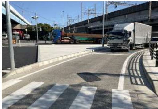
国道357号市川工区完成
