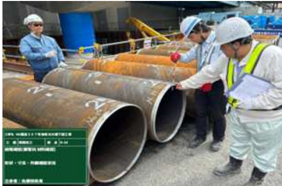
若手技術者による立会確認状況
