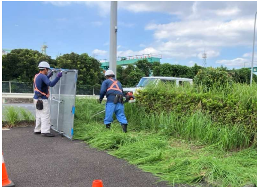
施工状況(除草工)
