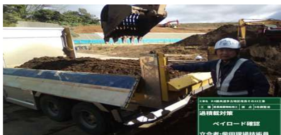
過積載対策として パイロードメータ装着油圧ショベルの使用状況
