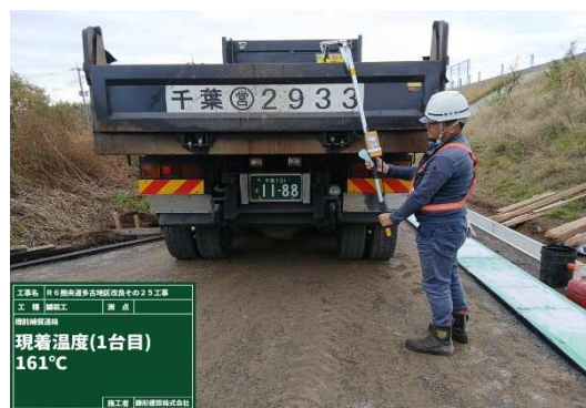
荷台に乗らず、 地上から合材温度を確認している状況
