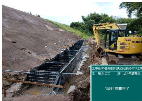
排水構造物設置状況
