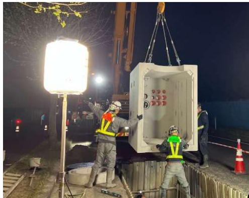
施工状況(電線共同溝特殊部設置)
