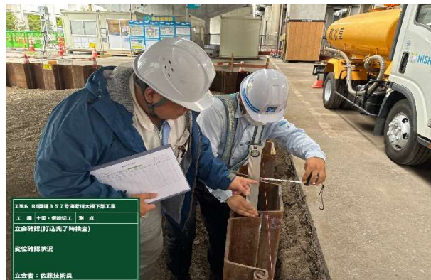
若手技術者による立会確認状況
