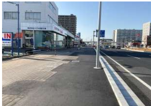
国道14号幕張工区完成
