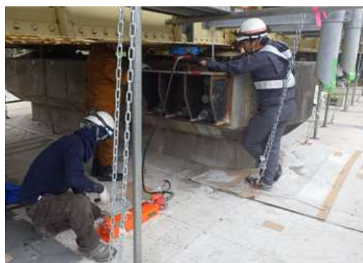
支承取替の状況
