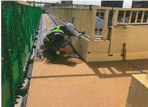
施工状況(横断歩道橋舗装打換え)
