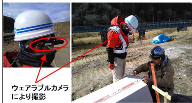
現場での受注者による撮影状況
