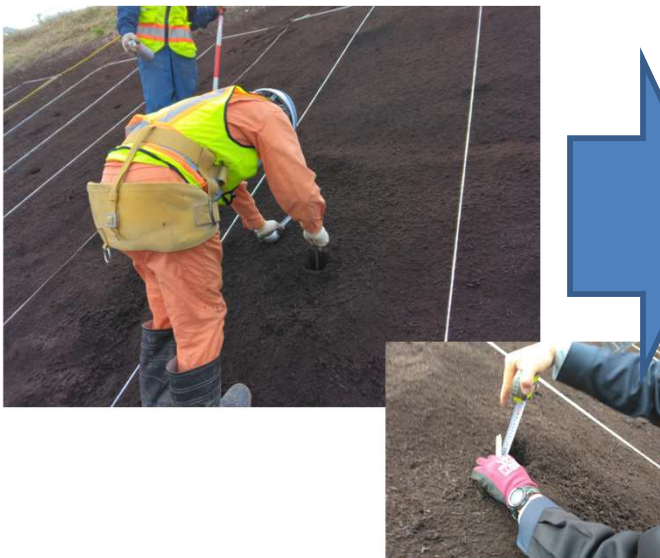
人力による出来形計測状況
