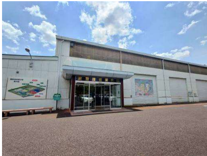
建設技術展示館 外観
