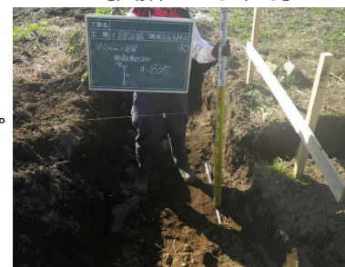
【試掘による確認】
