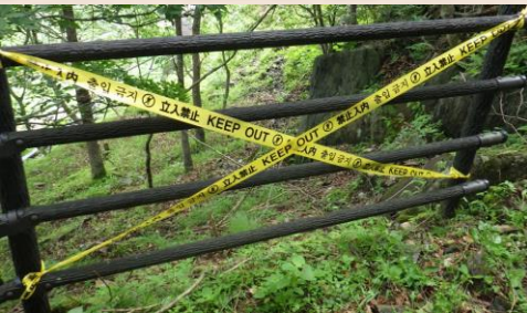
足尾砂防堰堤（足尾管内） 遊歩道転落防止柵の状況確認
