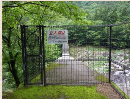
鳥居川上流一号砂防堰堤（大間々管内） フェンス・注意看板の状況確認
