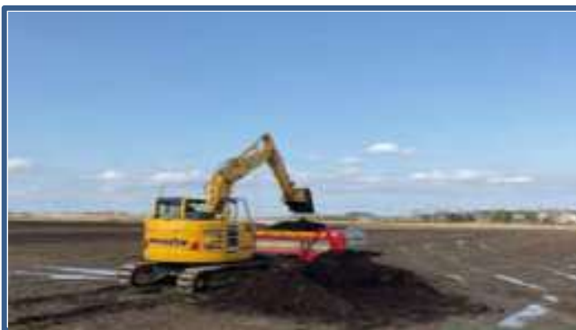
<土壌改良(堆肥積込)>
