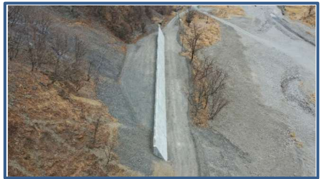
<写真2 施工箇所全景>
