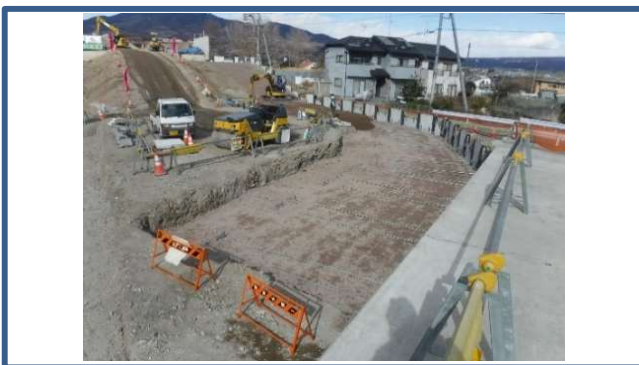
補強土壁施工状況
