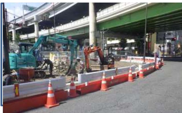
<写真1 施工状況>
