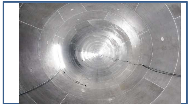
＜写真2 シールドトンネル完成＞
