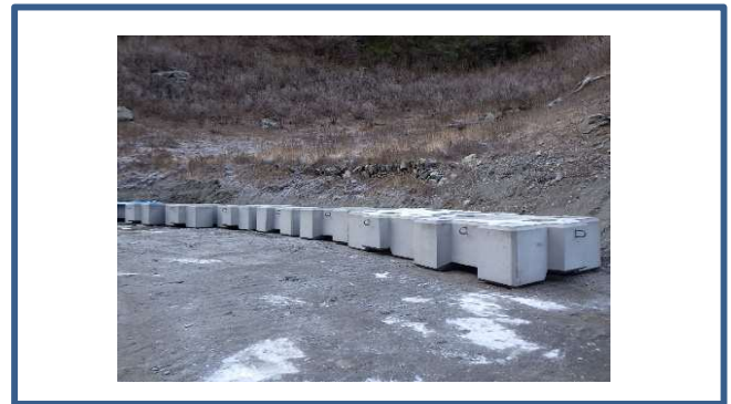
<写真2 根固ブロック製作工完了>
