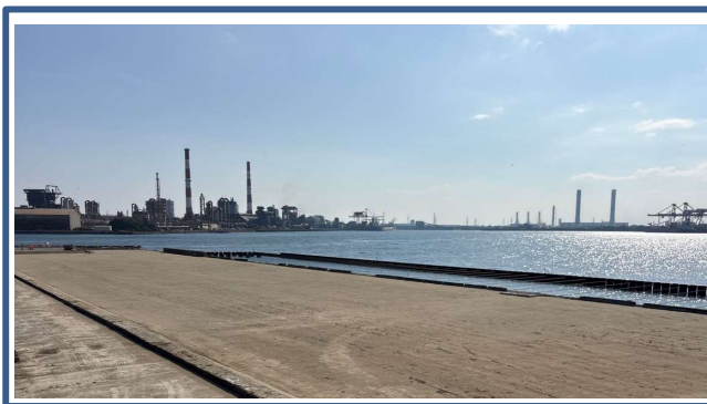
<写真1 工事完成>
