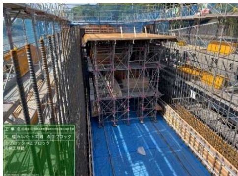
施工状況(移動式支保工の組立状況)
