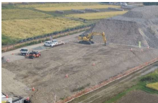
<路体盛土工 (ICT) 施工状況>
