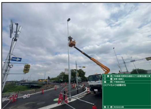
<CCTVカメラ据付け>
