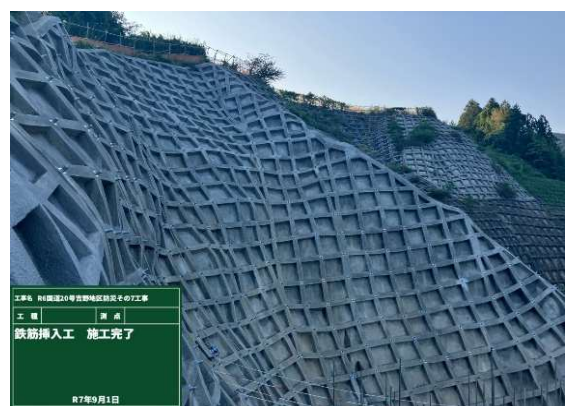
<写真2 鉄筋挿入工(完成)>
