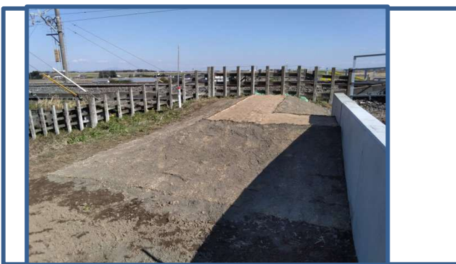
<写真1 堤防開口部の盛土>
