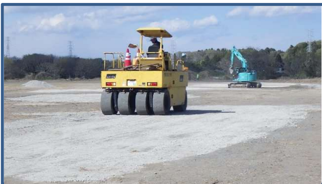
駐車場施工状況
