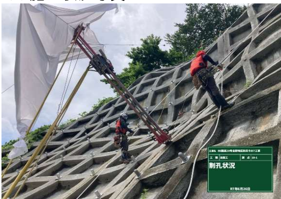
<写真1 鉄筋挿入工(施工状況)>
