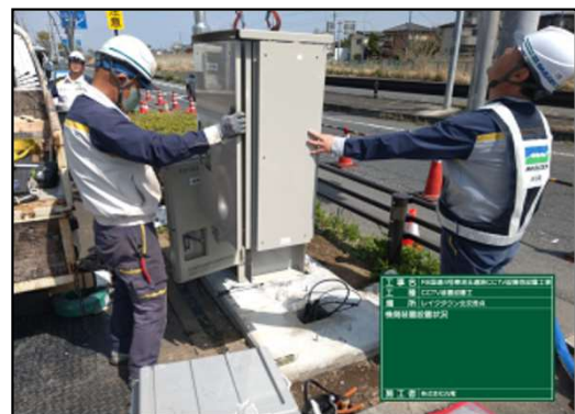
<機側装置据付け>
