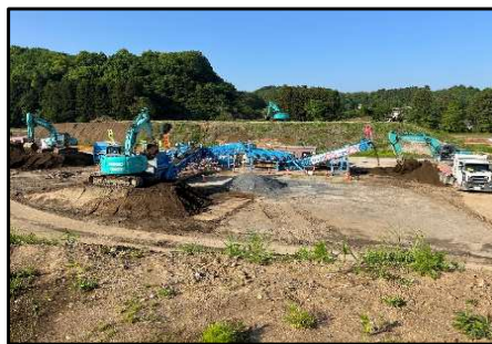
＜写真2 土砂改良状況＞
