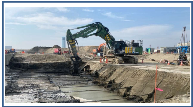
<写真2 中層混合処理工>
