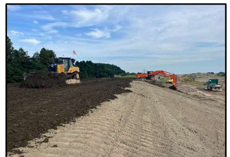
＜写真3 築堤盛土状況＞
