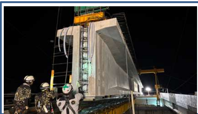
<写真1 桁架設状況>
