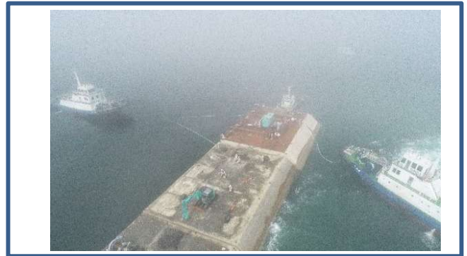
<ケーソン据付状況>
