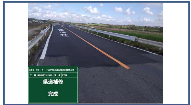
＜緊急道路補修完成＞
