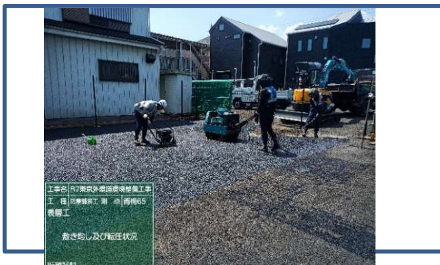
<写真1 防塵舗装施工状況>
