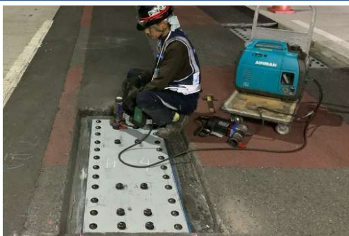
<写真1 当て板補修>
