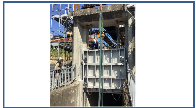
<写真2 施工状況(扉体据付)>
