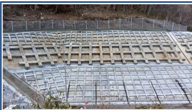
<写真1 法面復旧工事全体>
