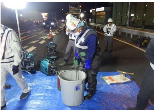
＜路面下空洞による流動化材の注入作業＞
