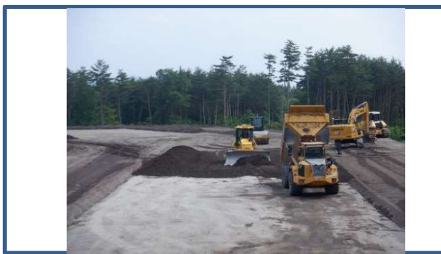
砂防ソイルセメント工 巻き出し転圧施工状況
