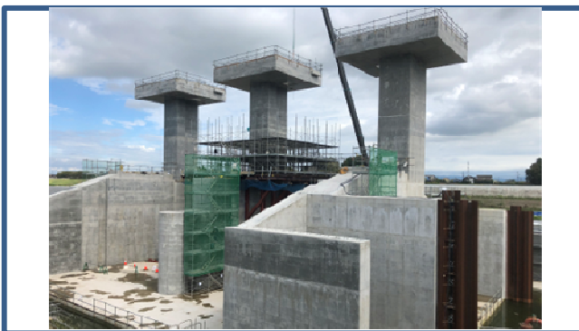
門柱・操作台・翼壁 施工状況
