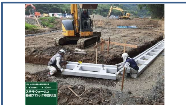
<写真1 小貫SY施工状況>
