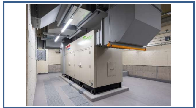
発電機室施工状況
