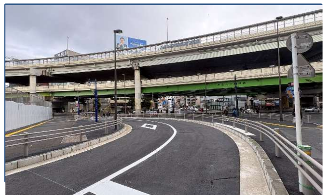
<写真2 完成写真>
