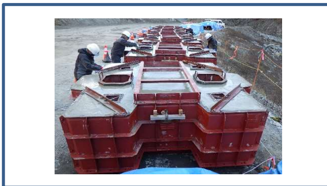
<写真1 根固ブロック製作工施工状況>
