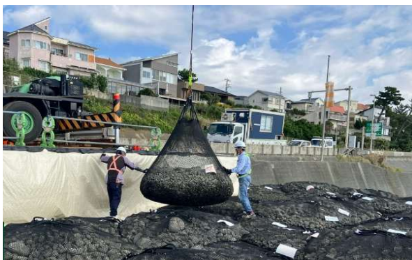
<写真1 袋詰め玉石 設置状況>
