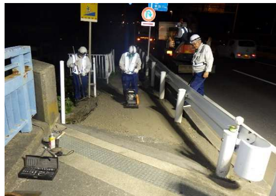
＜歩道段差補修作業＞
