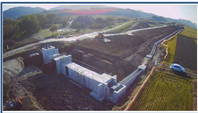
<写真1 施工中(奥:堤防、手前:排水樋管)>
