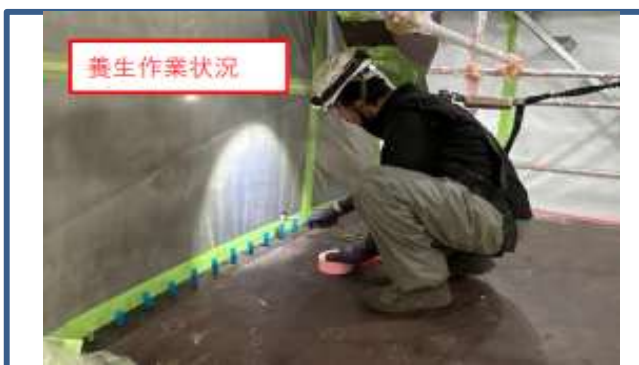
<写真1 塗装不可部分の養生状況>
