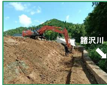
基礎ブロックの床掘を行っています
