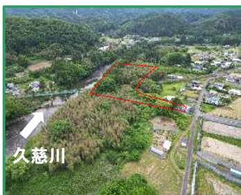
工事箇所の全景（上流から）
