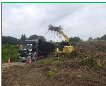
竹根の積み込み作業を行っています
