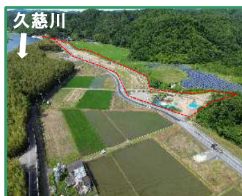
工事箇所の全景（下流から）
