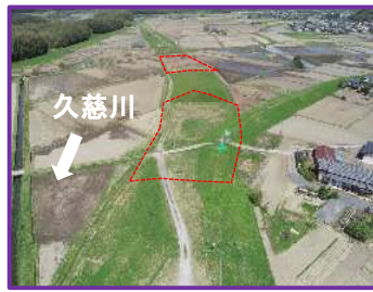
工事箇所の全景（下流から）
