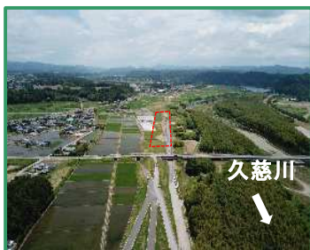
工事箇所の全景（下流から）
