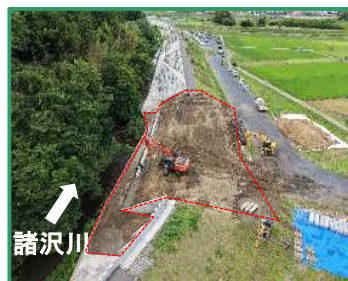
工事箇所の全景（上流から）
