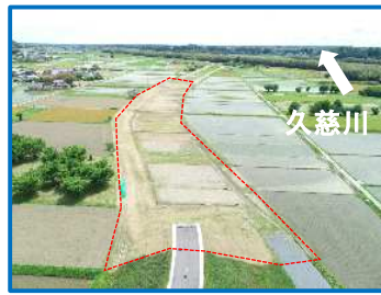
工事箇所の全景（上流から）
