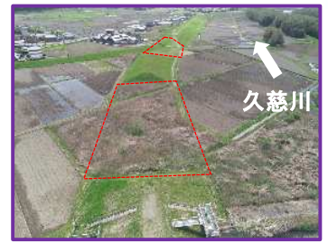
工事箇所の全景（上流から）
