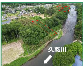
工事箇所の全景（下流から）
