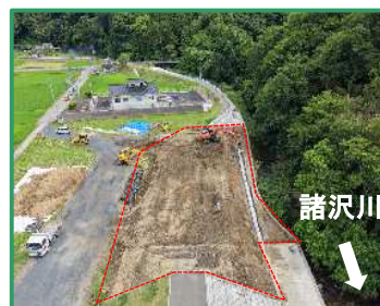
工事箇所の全景（下流から）
