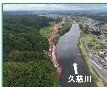
工事箇所の全景（上流から）
