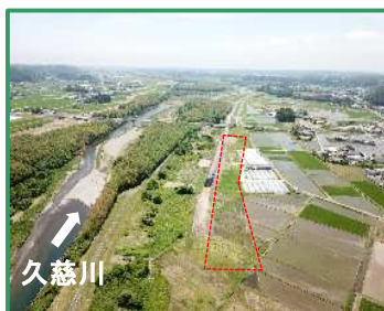
工事箇所の全景（上流から）
