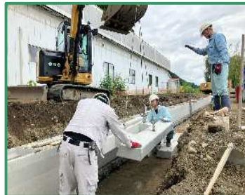
ブロック積みを行っています
