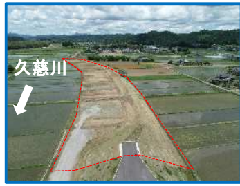
工事箇所の全景（下流から）
