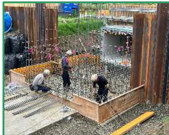
樋管部の鉄筋組立を行っています
