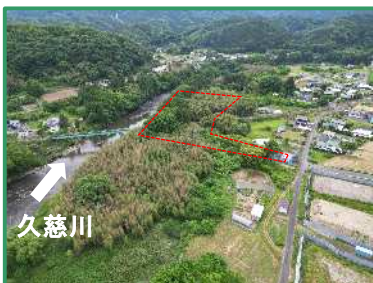
工事箇所の全景（上流から）
