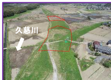
工事箇所の全景（下流から）
