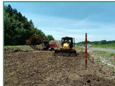
築堤のための盛土作業を行っています
