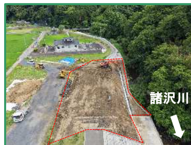
工事箇所の全景（下流から）
