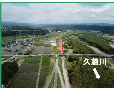
工事箇所の全景（下流から）
