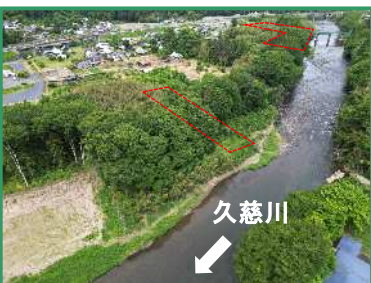
工事箇所の全景（下流から）
