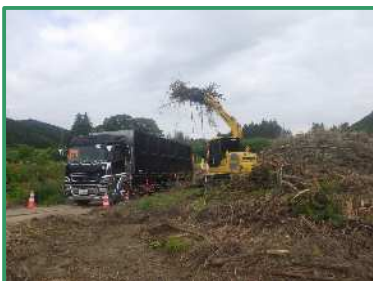
竹根の構込み作業を行っています
