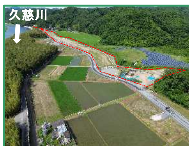
工事箇所の全景（下流から）
