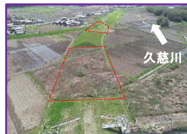
工事箇所の全景（上流から）
