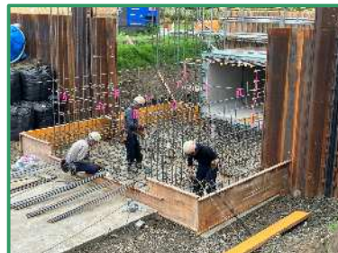
樋管部の鉄筋組立を行っています
