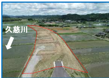
工事箇所の全景（下流から）
