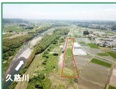
工事箇所の全景（上流から）
