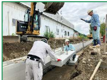
ブロック積みを行っています
