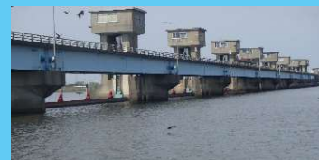
利根川河口堰
