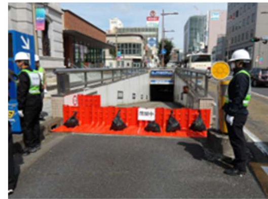
入庫口にて、止水板の設置手順及び正常に設置できるか確認
