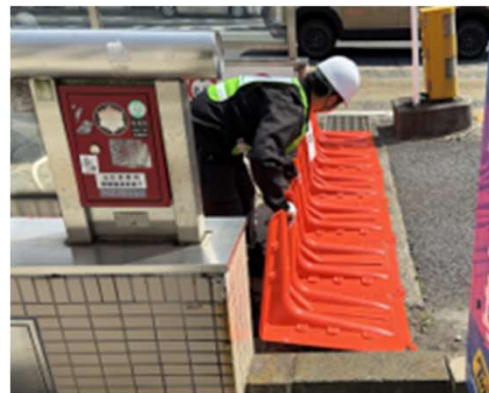
入庫口にて、止水板の設置手順及び正常に設置できるか確認
