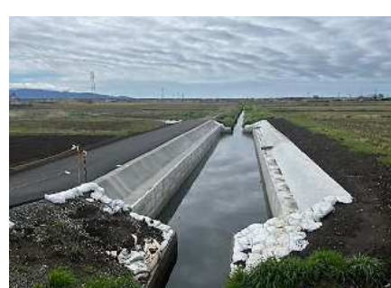
雨水排水路の改修
