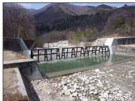
尾白川第三砂防堰堤
