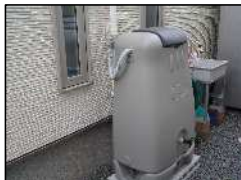
貯留槽の整備事例（富士市）
