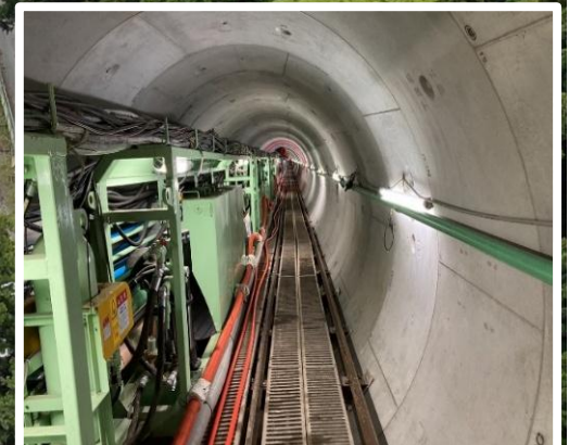
大芦川導水路施工状況(R4.3.10撮影)
