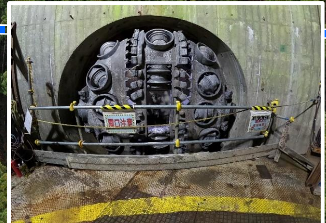
黒川導水路到達状況(R7.2.4撮影)
