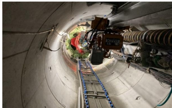
黒川導水路施工状況(R4.3.10撮影)
