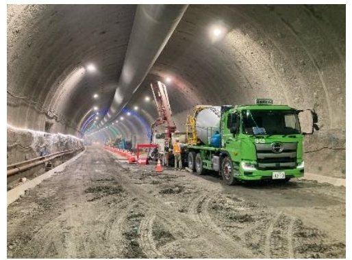
山清路トンネルの作業状況
