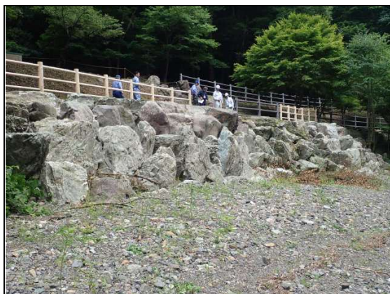
▲野栗沢砂防堰堤(キャンプ場付近)
