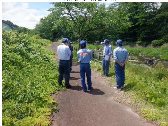
▲土出床固群(遊歩道付近)
