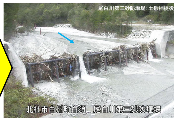
写真3: 流木、土砂捕捉効果事例
