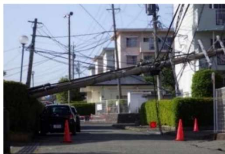
熊本地震における電柱倒壊例
