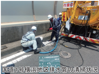
国道1号横浜地区排水管の清掃状況
