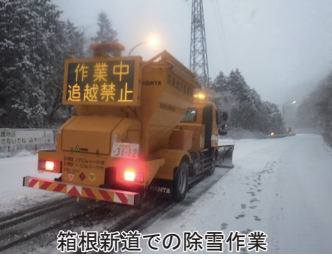
箱根新道での除雪作業
