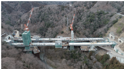
②やどりき双扇橋 (工事中名称：中津川橋) (松田町) の工事状況 (R8年2月撮影)
