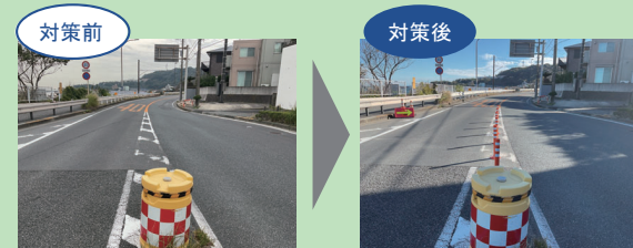
馬堀海岸地区のポストコーン設置例(Uターン防止対策)
