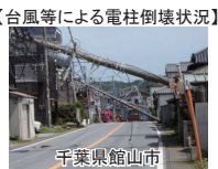
【台風等による電柱倒壊状況】 千葉県館山市
