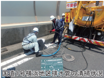
国道1号横浜地区排水管の清掃状況
