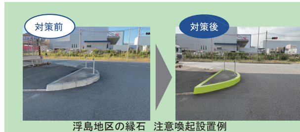
浮島地区の緑石 注意喚起設置例
