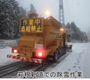
箱根新道での除雪作業
