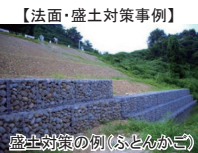
【法面・盛土対策事例】 盛土対策の例(ふとんかご)
