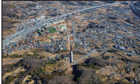
厚木秦野道路の空撮
