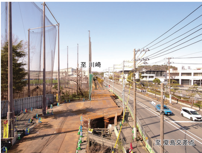
②横須賀市夏島町 改良工事状況 (令和8年6月撮影)
