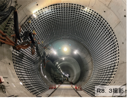
シールド2号機：マシン解体及び機内覆工完了
