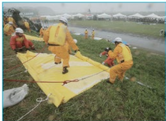
水防マット工
