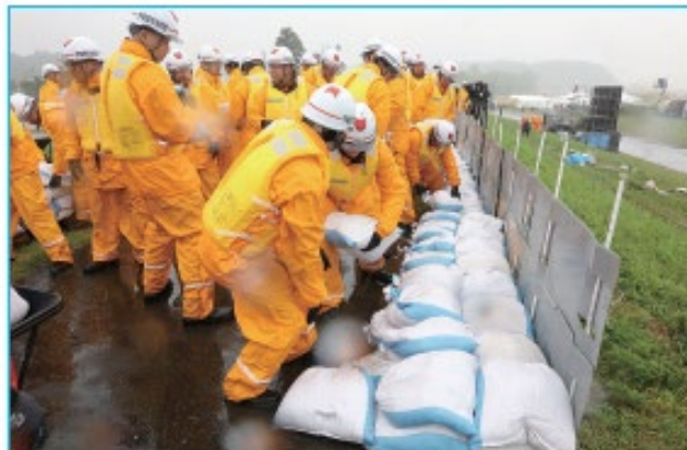
改良積み土のう
