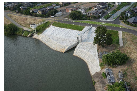
③古八間排水樋管(R7年8月完成)
