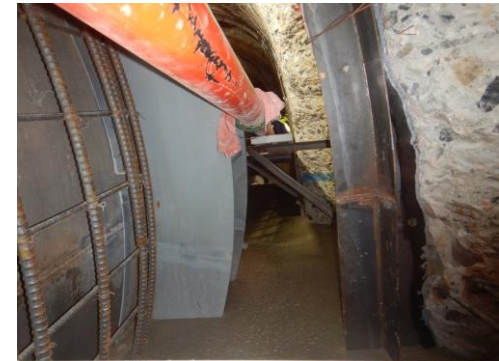
【放流設備工(コンクリート工)】 （撮影日：R8.6.11）
