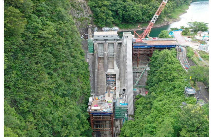
【水門据付工(小容量放流管設置)】 （撮影日：R8.6.26）
