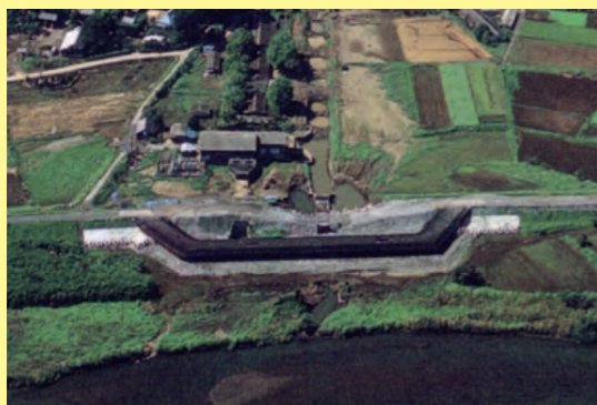
二重締め切りによる仮堤防
