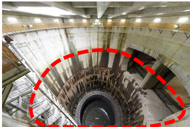
第1立坑から調圧水槽への流入状況
