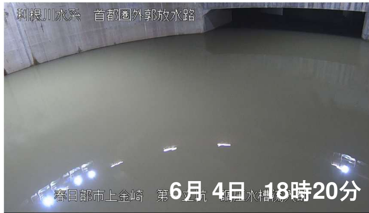
第1立坑から調圧水槽への流入状況
