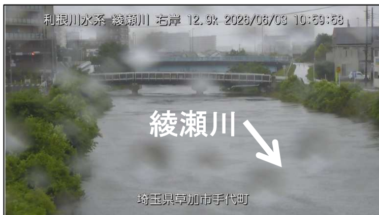
綾瀬川出水状況(埼玉県草加市付近)
