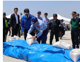
統監部への 浸水防止工法の説明 （改良積土のう工法）
