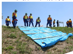
洗掘防止工法実施 （シート張り）
