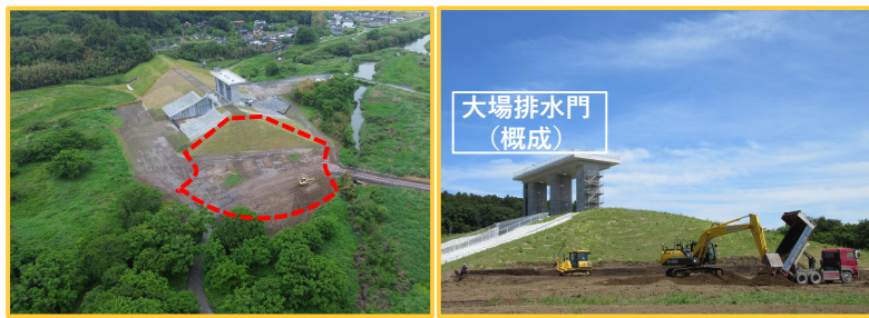
工事箇所の全景
