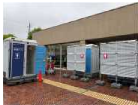
快適トイレの設置
