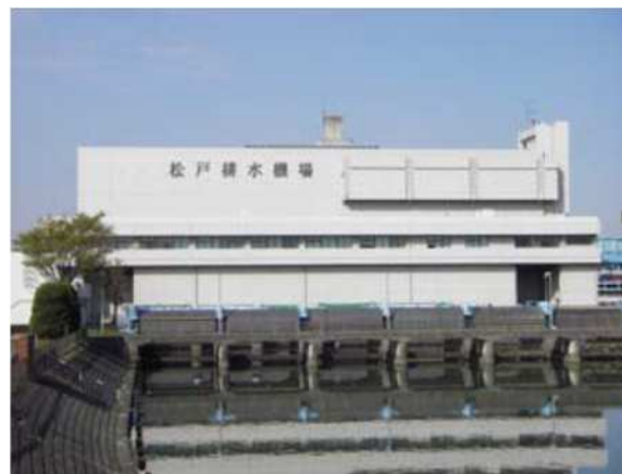
第三機場(千葉県松戸市)
