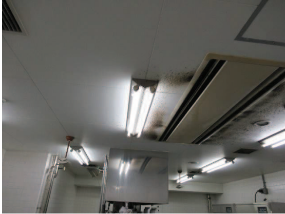
学生棟 洗浄室
