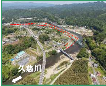
工事箇所の全景 (下流から)
