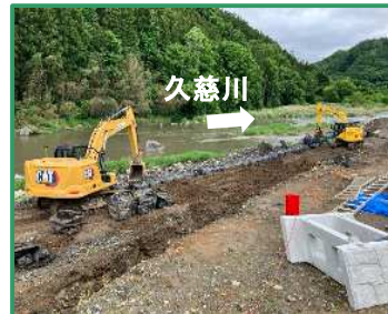
仮締切りを撤去しています
