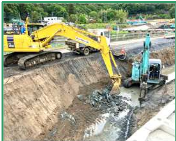
護岸基礎の床掘を行っています
