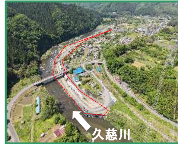
工事箇所の全景 (上流から)
