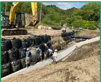
ブロック基礎の間詰めを行っています
