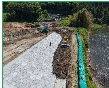
護岸ブロックの埋戻しを行っています
