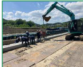
ブロック積みを行っています
