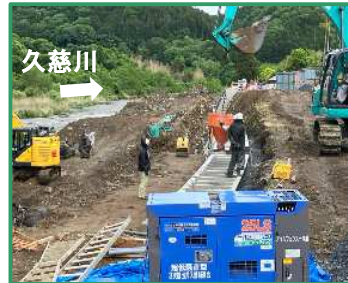
ブロック積みを行っています
