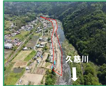
工事箇所の全景 (下流から)
