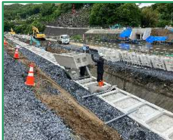
ブロック積みを行っています
