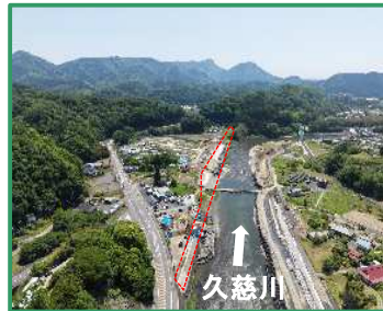
工事箇所の全景 (上流から)
