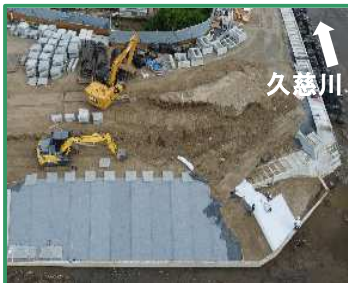
護岸ブロックを設置しています
