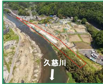
工事箇所の全景 (下流から)
