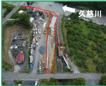
工事箇所の全景 (支流から)
