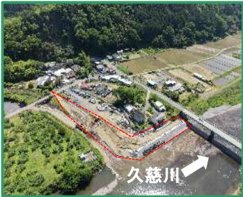
工事箇所の全景 (右岸から)
