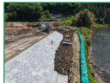
護岸ブロックの埋戻しを行っています
