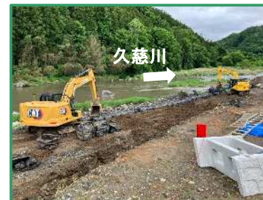
仮締切りを撤去しています
