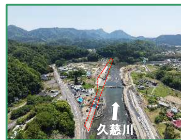
工事箇所の全景（上流から）
