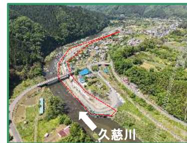
工事箇所の全景（上流から）
