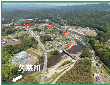
工事箇所の全景（下流から）
