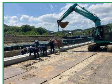
ブロック積みを行っています
