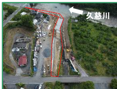
工事箇所の全景（支流から）
