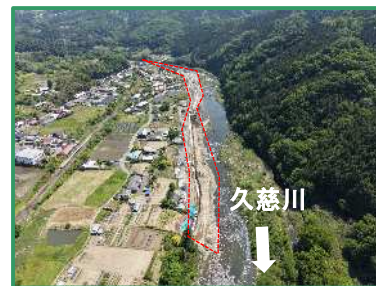
工事箇所の全景（下流から）
