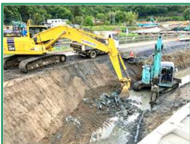
護岸基礎の床掘を行っています
