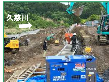
ブロック積みを行っています
