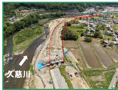
工事箇所の全景（上流から）
