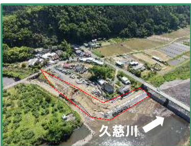
工事箇所の全景（右岸から）
