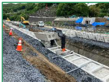
ブロック積みを行っています
