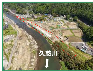
工事箇所の全景（下流から）
