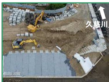
護岸ブロックを設置しています
